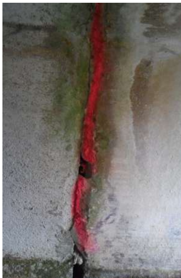
Obr.4 spáry mezi prefabrikáty
