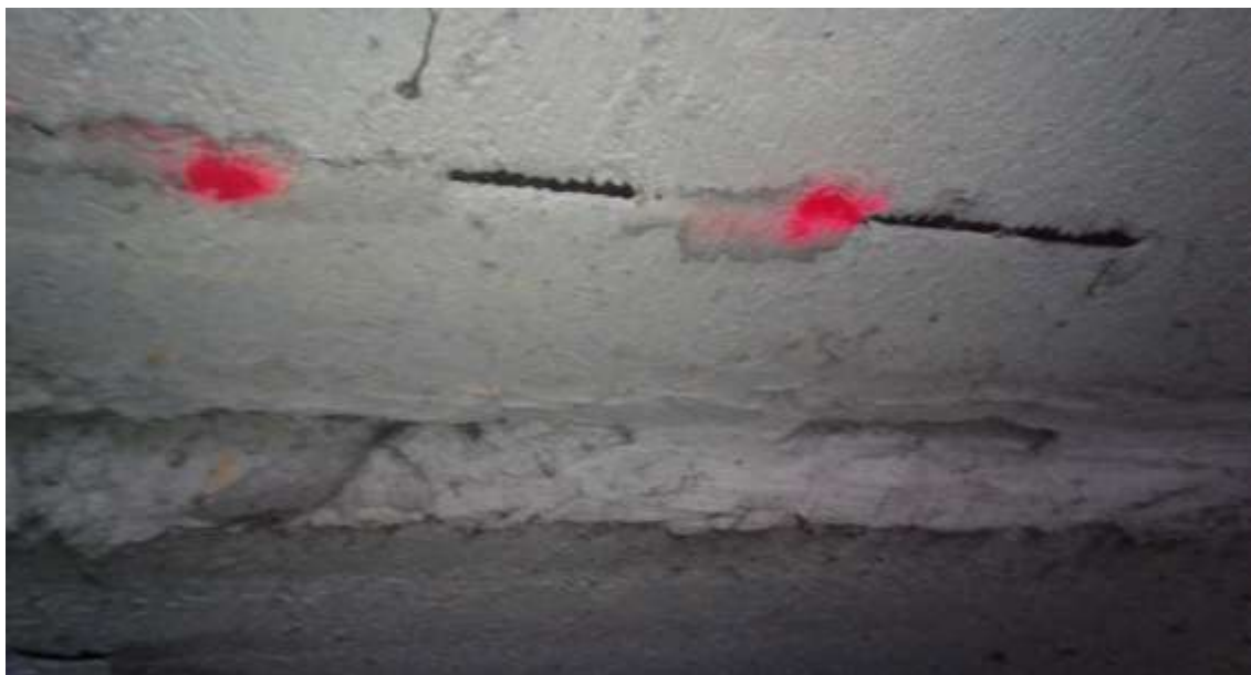
Obr. č.1 Korodující výztuž nosné konstrukce mostku
